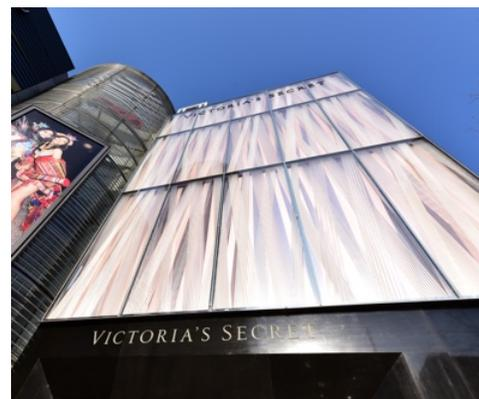
Il Plexiglas è stato scelto per la sua elevata trasparenza e flessibilità: grazie ad una trasmissione della luce che arriva al 92%, il materiale conferisce all'edificio un aspetto chiaro e trasparente; al tempo stesso, soddisfa i requisiti di progetto per quanto concerne la resistenza alle intemperie e il mantenimento della trasparenza anche dopo una lunga esposizione ai raggi solari.
