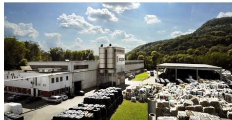
L'installazione di una nuova linea di ultima generazione per il riciclo di film in polietilene ha incrementato del 60% la capacità dell'impianto (in precedenza pari a circa 35mila tonnellate annue), in grado di trattare sia sfrido industriale che rifiuti post-consumo.
