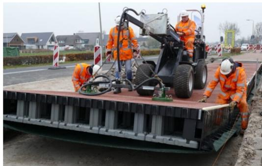
PlasticRoad è una sorta di scatolato prefabbricato cavo e leggero, all'interno del quale vengono fatti passare condotte e cablaggi, posato su un sottofondo sabbioso. La struttura sarà inizialmente utilizzata per realizzare piste ciclabili, pavimentazioni di parcheggi, banchine ferroviarie e marciapiedi.
