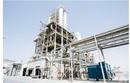
Le due unità avranno, ognuna, una capacità pari a 400.000 tonnellate annue di polipropilene e saranno integrate in un un complesso per la produzione di propilene (840.000 t/a) mediante deidrogenazione di propano e successiva polimerizzazione.
