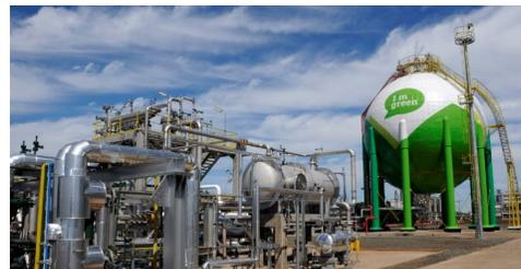
Questa tecnologia di processo viene impiegata con successo da oltre un decennio nel polo Braskem di Triunfo, in Brasile, per la produzione di etilene biobased destinato alla successiva sintesi di polietilene e derivati (EVA).
