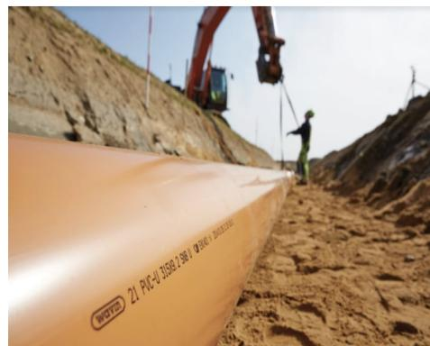
Nella nuova gamma di tubi e raccordi, il PVC è ottenuto partendo da etilene bio-attribuito, dove parte delle materie prime fossili è sostituito con feedstock biobased, quali oli vegetali derivanti da rifiuti o sottoprodotti. Questi vengono attribuiti all'etilene e poi al PVC mediante bilancio di massa certificato ISCC Plus, a garanzia della trasparenza lungo la filiera.
