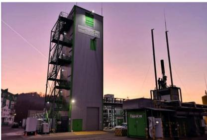
Il processo sviluppato dalla società tedesca si basa sulla pirolisi, da cui si ottiene un olio che, una volta purificato, può sostituire materie prime fossili utilizzate dall'industria chimica per produrre intermedi e, da questi, anche plastiche e gomme. Come sottoprodotto del processo si ottengono anche gas e carbon black di recupero (rCB).
