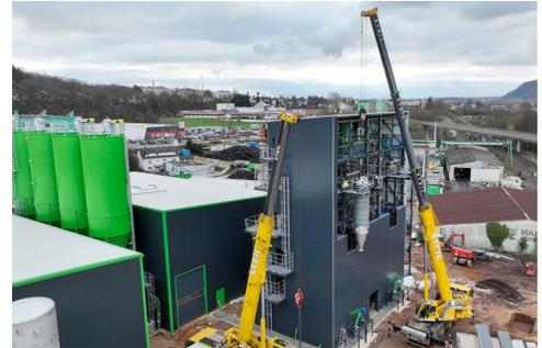
Nei giorni scorsi è stata completata l'installazione di ulteriori due reattori di pirolisi, che saranno collaudati nei prossimi giorni attraverso test di loop check, che precedono il commissioning a freddo degli impianti. A regime, la capacità di trattamento di PFU raggiungerà 20.000 tonnellate annue.
