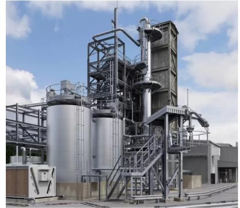
Installato presso il complesso di Wilton International, l'impianto tratterà frazioni rigide e flessibili dei flussi di rifiuti da imballaggio, tra cui film non recuperabili mediante riciclo meccanico. La capacità di trattamento è pari inizialmente a 20.000 tonnellate annue, con possibilità di triplicarla in futuro. L'unità occupa una cinquantina di addetti diretti.
