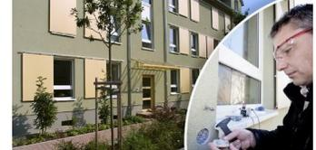
L'isolamento a cappotto (Etics) è stato analizzato da un esperto indipendente, che ha giudicato in condizioni molto buone sia il pacchetto isolante che l'intonaco di rivestimento. Non è stata riscontrata la presenza di muffe o di segni visibili di invecchiamento, mentre campioni della facciata, dopo un'attenta analisi, hanno confermato il buono stato del pacchetto isolante. Gli standard tedeschi indicano per i sistemi Etics (isolamento a cappotto in facciata) una durata media di quarant'anni.
