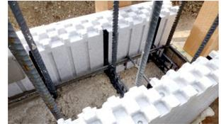
I sistemi costruttivi SAAD (Sistemi ad Armatura Diffusa) coniugano la resistenza meccanica del calcestruzzo con la capacità di isolamento termico e acustico dell'EPS, allo scopo di creare elementi in cemento armato isolati. Evoluzione della prefabbricazione verso una maggiore qualità costruttiva, si basano su elementi collegati tra loro con semplici e veloci operazioni a secco, fino a formare una casseratura in polistirene che riceve il getto di calcestruzzo e lo porta a maturazione.
