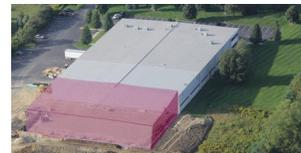
Si tratta della seconda espansione dal 2000, anno di costruzione dello stabilimento. I nuovi reparti, alti 10 metri per poter accogliere presse di grande taglia, ampliaranno di 1.850 m2 la superficie complessiva della fabbrica. La nuova ala sarà completata nel gennaio 2014.
