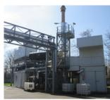
L'impianto, progettato e realizzato dalla società di servizi energetici (E.S.CO.) Heat & Power, si basa su un motore endotermico da 2MW elettrici alimentato a gas naturale e dotato di un assorbitore a bromuro di litio per la produzione di acqua fredda.
