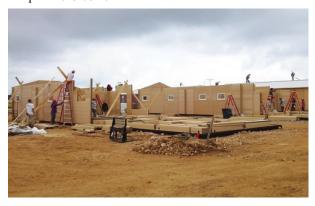
Strutture ospedaliere di emergenza costruite con composito legno-plastica (WPC) sono state sperimentate con successo nelle Filippine dopo il passaggio del tifone Haiyan, per fornire assistenza medica alle vittime. Il materiale Ã" composto al 75% da farina di legno proveniente da riciclo o da residui di produzione, tenuta insieme da un legante polimerico, in questo caso polipropilene.
