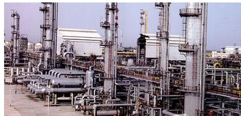
La nuova unità utilizza tecnologia di processo Unipol PE di Univation Technologies, che consente di produrre polietilene ad alta densità e a bassa densità lineare (HDPE/LLDPE), offrendo a Gail la necessaria flessibilità per seguire gli andamenti del mercato indiano.
