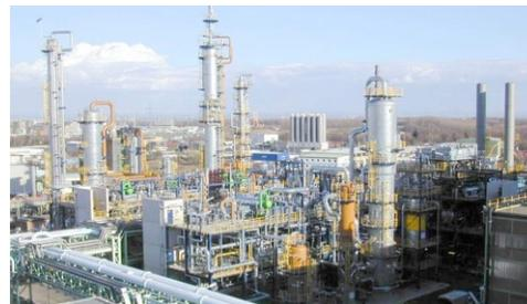
Per la produzione di cloro sarà impiegata la più recente tecnologia a membrana di ThyssenKrupp Uhde, caratterizzata da efficienza energetica e basso impatto ambientale, mentre per aumentare la capacità di VCM, in due fasi che si completeranno nel 2021, sarà impiegata una tecnologia di processo proprietario.
