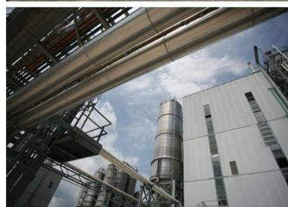
Il sito di Patrica era stato rilevato da Novamont al fine di riconvertirne la produzione dal PET ai poliesteri biodegradabili ottenuti da monomeri a partire da oli vegetali. Inizialmente il gruppo novarese ha messo in marcia solo una delle due unità di polimerizzazione presenti nel sito; nei primi mesi di quest'anno è stata trasformata anche la seconda linea.
