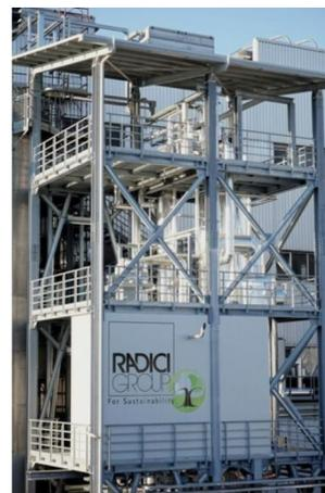
L'impianto - spiega la società bergamasca - consente di recuperare l'acqua derivante dal processo di polimerizzazione, in cui vi è una concentrazione del caprolattame intorno all'8-12%: grazie alle tecnologie del Falling Film e della Ricompressione Meccanica del Vapore è possibile portare la concentrazione finale del caprolattame all'80%, così da reimpiegarlo nella produzione a ciclo continuo del polimero.
