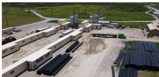
Una intera linea di estrusione tubi in polietilene ad alta densità può essere caricata su camion e trasportata in cantiere per essere operativa in sole 72 ore, senza dover realizzare infrastrutture fisse. Terminata l'installazione dei tubi, l'impianto viene smontato e trasferito nel successivo sito di produzione.
