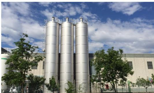
I silos monolitici prodotti in Italia dispongono di un cappello brevettato ricavato da fondo bombato, che garantisce una completa robustezza dei piani di calpestio e una maggiore resistenza in presenza di repentine variazioni della pressione interna. Per la versione ad anelli viene impiegato il sistema brevettato Locked Silos System che agevola il trasporto e il montaggio anche in luoghi remoti del mondo garantendo
