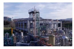
Realizzato da NextChem, società di Maire Tecnimont, l'impianto utilizza un processo di depolimerizzazione basato sulla reazione di idrolisi alcalina con utilizzo di microonde, al fine di ottenere i costituenti base delle resine polistere: glicole etilenico e acido tereftalico, monomeri puri da riutilizzare per produrre nuovi polimeri.
