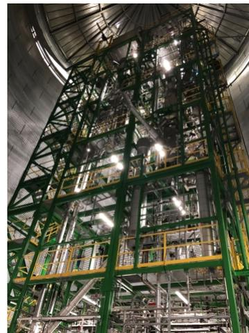
Basato su un catalizzatore proprietario e un sistema reattore-rigeneratore a letto fluido, il processo TCat-8 può funzionare 24 ore su 24, 7 giorni su 7, convertendo la plastica contenuta nei rifiuti misti, ad eccezione del PVC, in aromatici, olefine leggere e paraffine.
