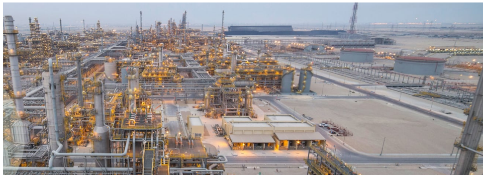
Tecnimont e Tecnimont
