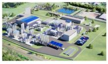
Il processo si basa sulla tecnologia C-Zyme sviluppata da Carbios, dove un enzima provvede a depolimerizzare PET e fibre poliestere, riportandoli ai costituenti di partenza: acido tereftalico e glicole monoetilenico; questi composti, dopo essere stati purificati, possono essere riutilizzati come monomeri per produrre poliestere con qualità pari al vergine e nuovamente
