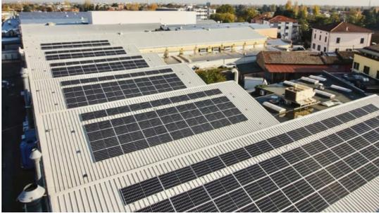
Sidel, società del gruppo Tetra Laval che opera nelle tecnologie per il packaging, ha avviato presso la sede di Parma un impianto fotovoltaico in grado di coprire il 40% del suo fabbisogno elettrico, riducendo le emissioni di CO2 di un volume stimato in 871 tonnellate l'anno.
